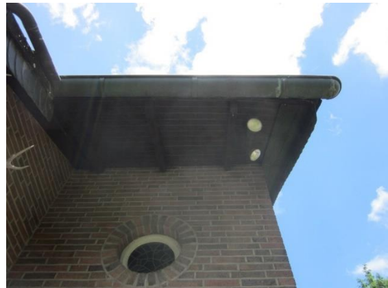
Abb. 6: Dachüberstand, Eckbereich (ISR 2024).
