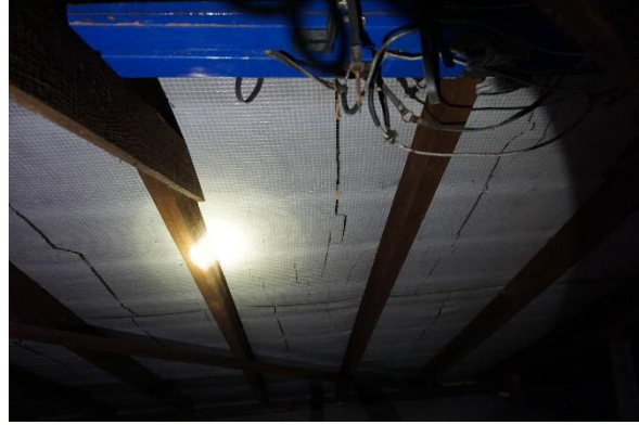
Abb. 18: Dachboden von Haus Nr. 8a (ISR 2024)
