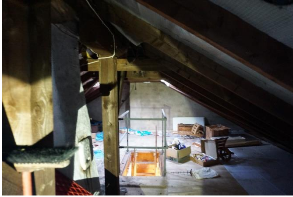
Abb. 17: Dachboden von Haus Nr. 8a (ISR 2024)
