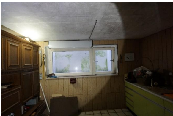
Abb. 19: Kellerraum, Haus Nr. 8a (ISR 2024)
