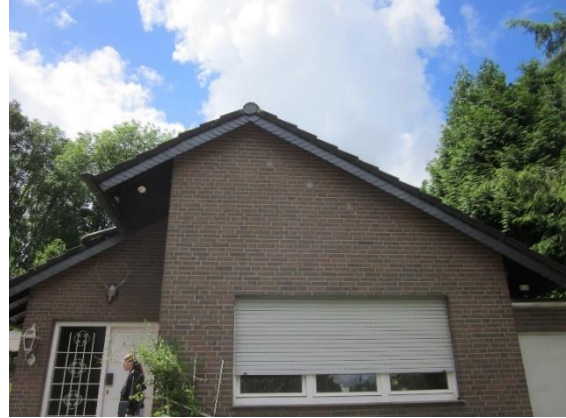
Abb. 4: Haus Nr. 8a, Giebelseite mit Schieferplatten (ISR 2024).
