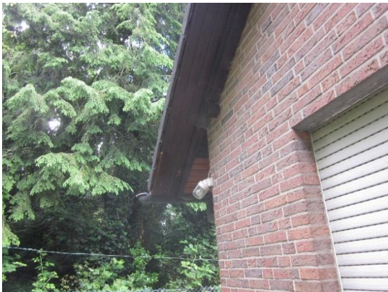
Abb. 5: Haus Nr. 8a, Dachüberstand mit Holzpaneelen (ISR 2024)
